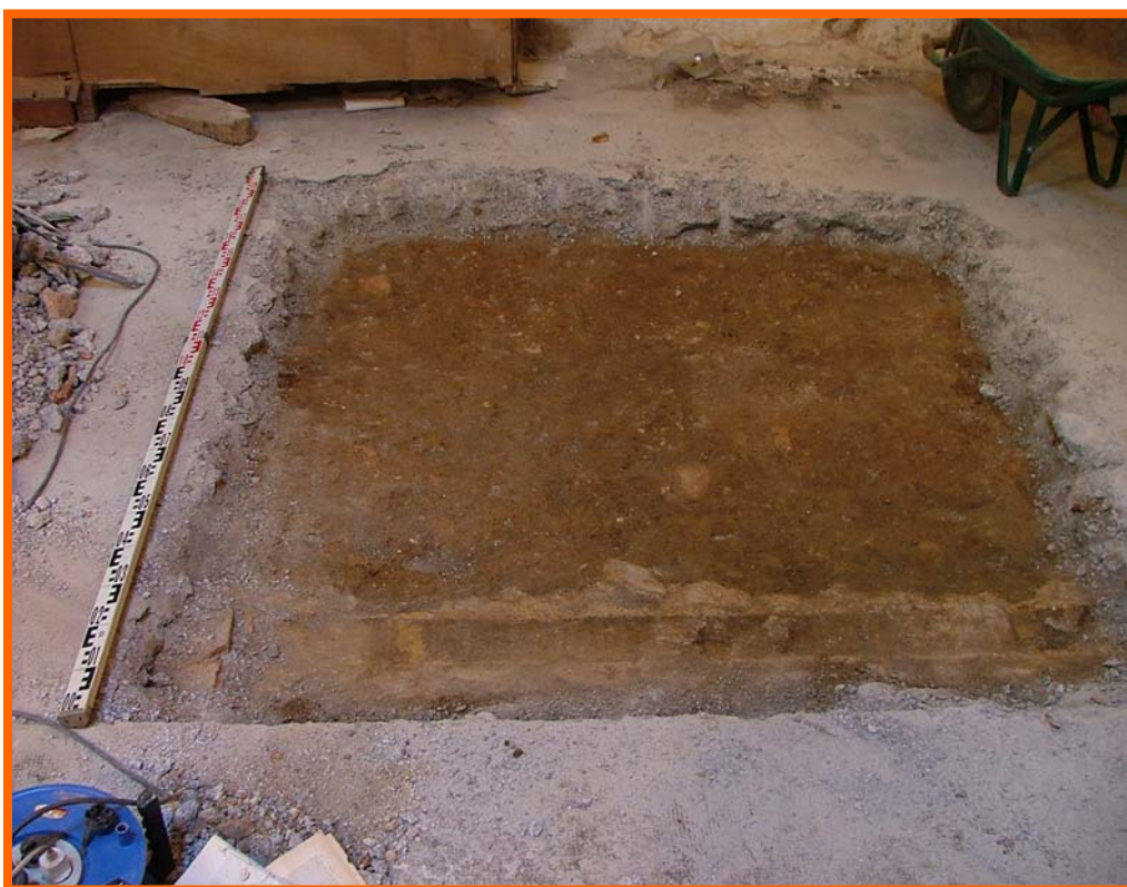
Fotografia 6. Inici del sondatge 2, un cop trencat el paviment de formigó actual.
